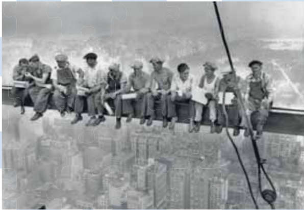
Dělníci na traverze Workers on girder
